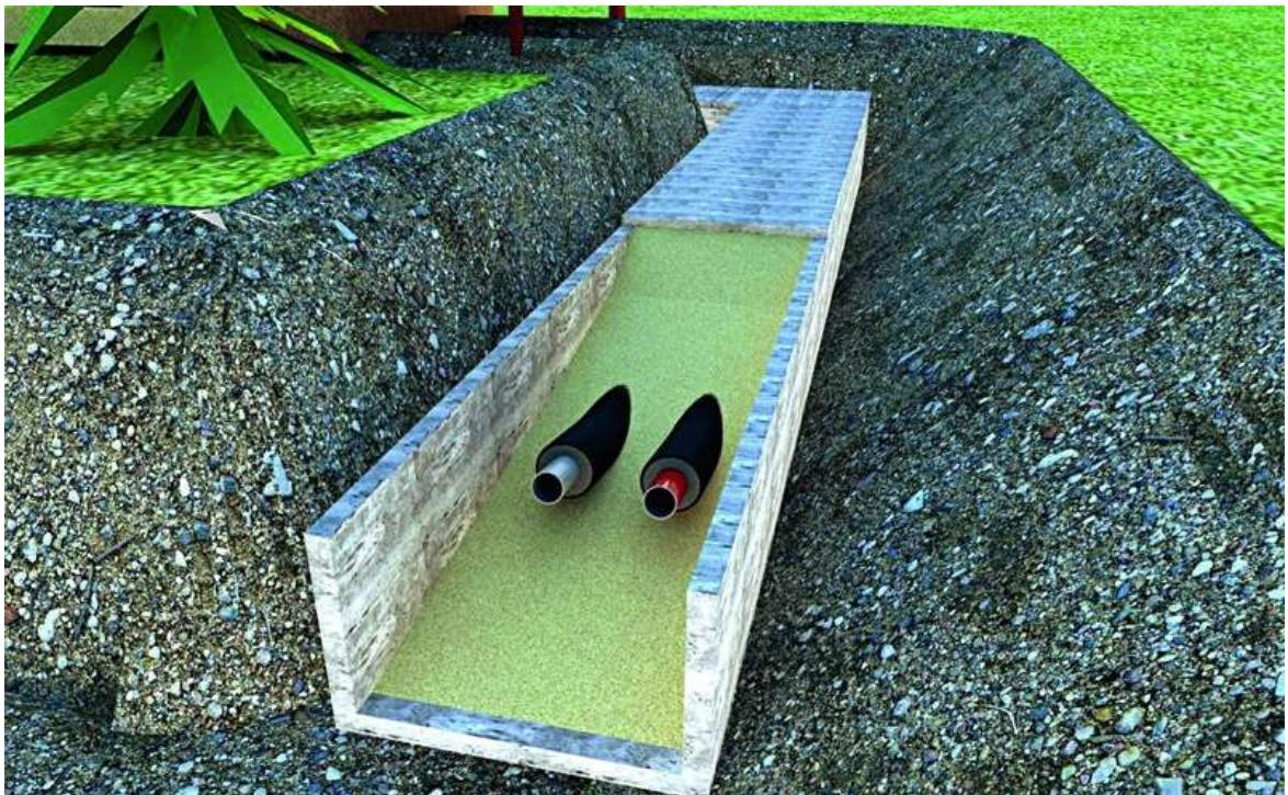
При прокладке FLEXALEN труб в непроходных каналах в ходе реконструкции тепловых сетей допускается прокладка в старых каналах с засыпкой песком. Создается песчаная подушка не менее 10 см., укладывается труба и засыпается песком не менее, чем на 10 см. над верхней поверхностью кожуха.
