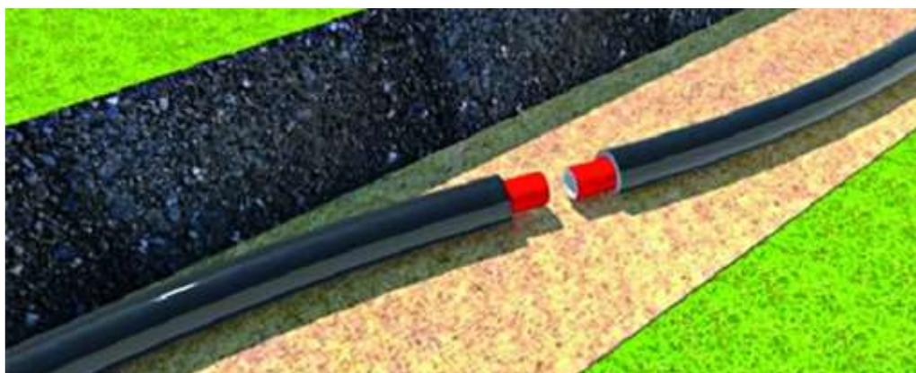
Правильно. Трубы лежат на плоскости, изгиб от остаточной деформации в разные стороны.
