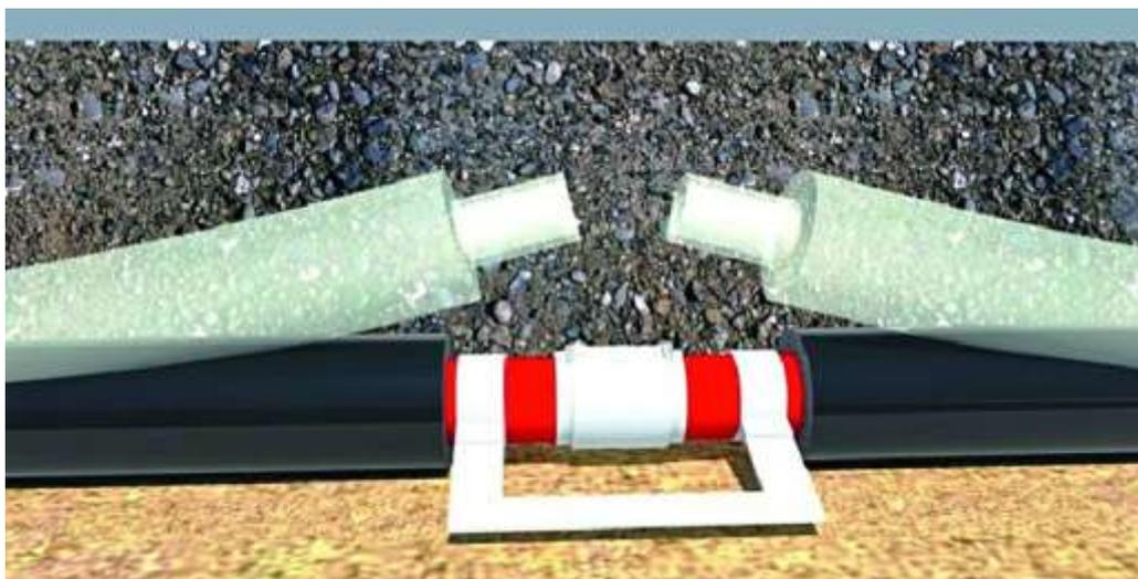
Правильно. Вариант 1. Использовать центрирующие струбцины во время сваривания до полного остывания.
